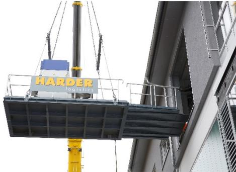
**Bildunterschrift:** Die Montageplattform ist eine sichere und professionelle Lösung, um schwere Einzelteile über die Fassade in oder aus einer oberen Etage zu verlagern.
